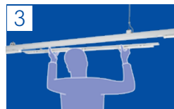
3 LED-Sanierungseinheit in vorhandene Trageschiene einsetzen.
